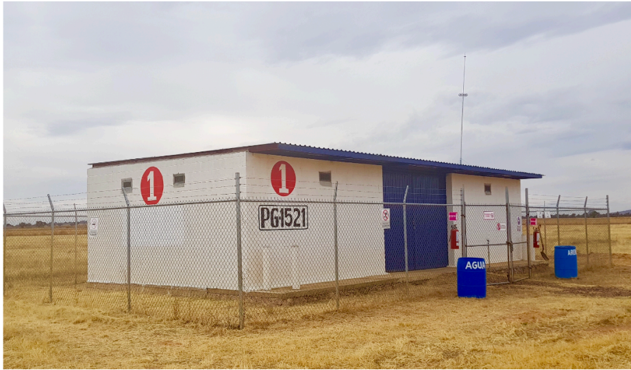
Polvorín de blocs con piso de cemento
